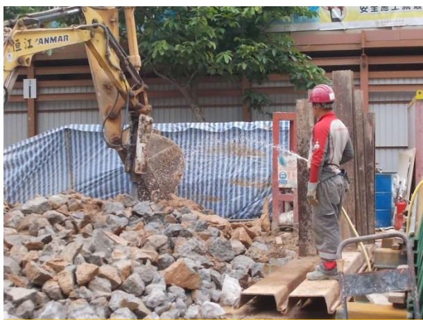
破碎及打樁工程中的尘埃抑制
