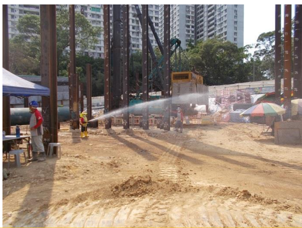
破碎及打樁工程中的尘埃抑制
