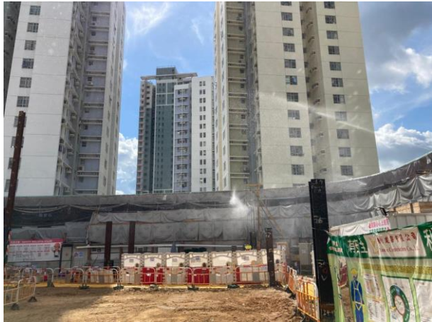
在围街顶部安装洒水雾头
