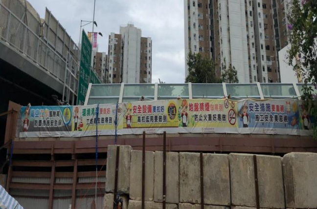
修身养性：在围街顶上悬挂大量横幅，加强工人的安全意识和文化
